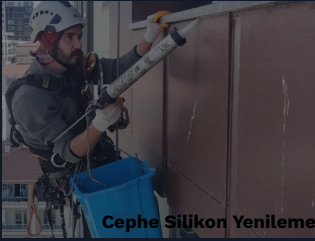
Cephe Silikon Yenileme
